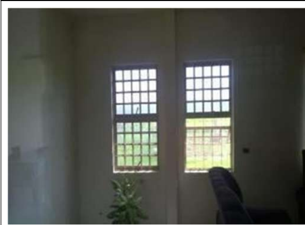
Figura 13. Vista interna da casa sede. (10.014)
