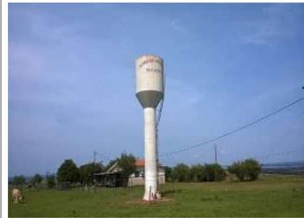
Figura 15. Caixa de água
